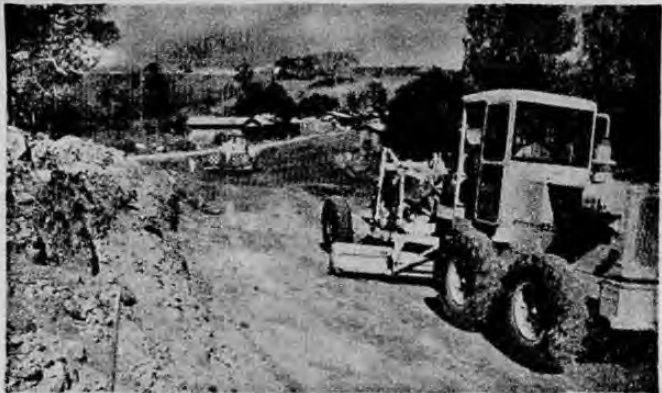
PROYECTO CAÑAS-TILARAN. —Con una extensión de 22.80 kilómetros, está siendo construido por la Compañía Constructora Rawcon de Costa Rica, con un valor de $4.000.000. Fue iniciado desde el año anterior y se espera esté listo para los próximos meses.
